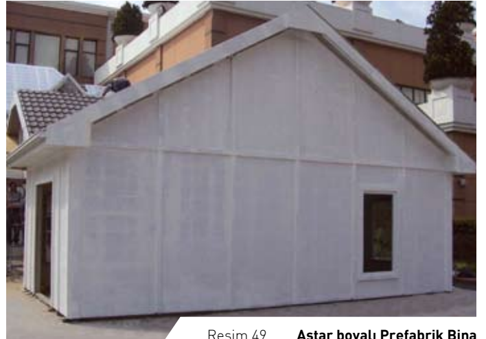
Resim 49 Astar boyalı Prefabrik Bina
