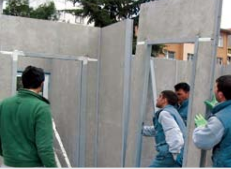
Resim 47 Prefabrik Bina İç Duvar Yapımı
