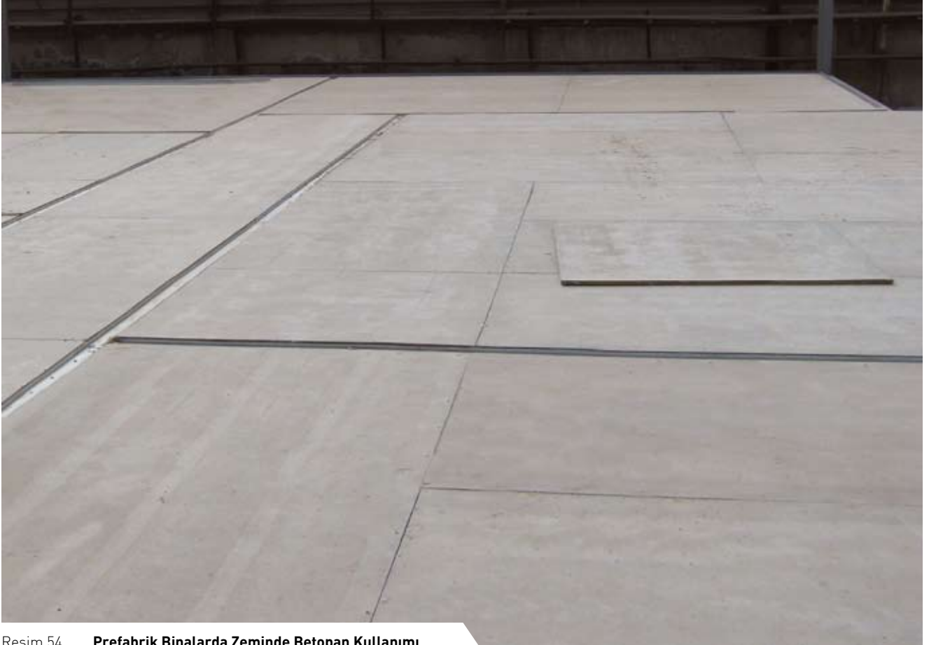
Resim 54 Prefabrik Binalarda Zeminde Betopan Kullanımı
